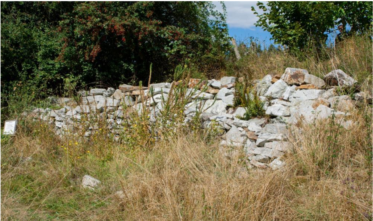
Abb. 20: Sonnensexponierte Trockenmauer als Lebensraum für Zauneidechse und CO. Foto | Marcel Weidenfeller
